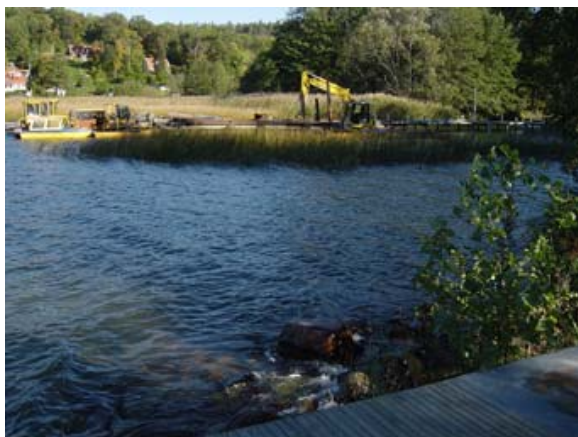
Figur 139. Undersökningslokalen i Mälaren vid Viksberg. Pålningsarbete pågår på motsatta stranden. Foto: Stefan Lundberg.
