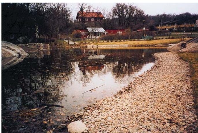
Figur 9. Dammen i östlig riktning den 3 oktober 2004.
